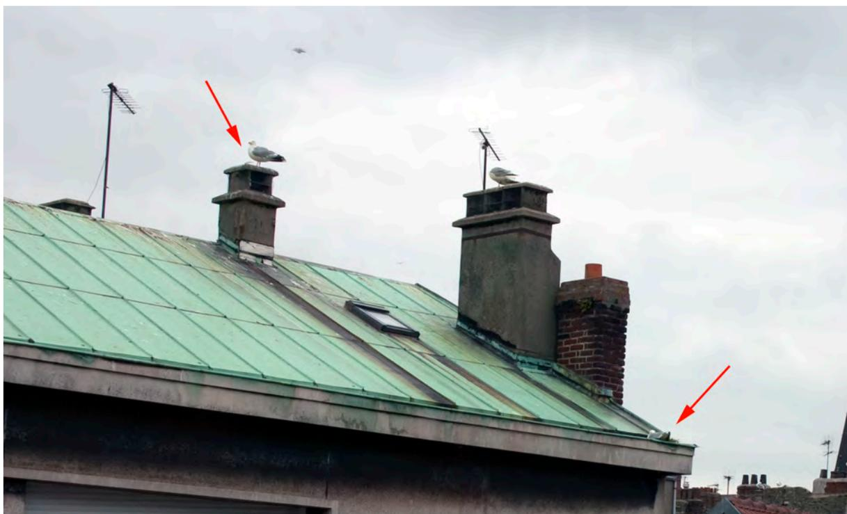
Photo 5.- La pose de pics sur les cheminées et dans les chéneaux empêche la construction des nids © Alain Ward
